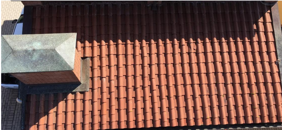
Figura 8. Tejado norte después de la limpieza.
