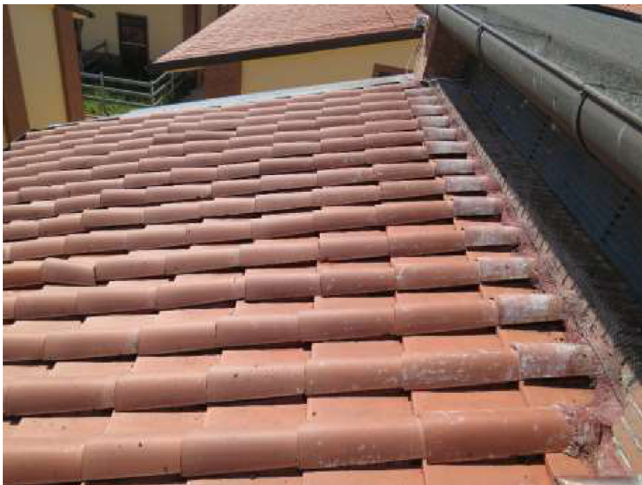
Figura 3. Tejado sur después de la limpieza.
