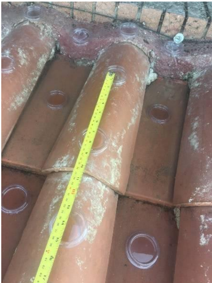
Figura 9. Tejado norte tratado con platos de PET vacíos, como "control".
